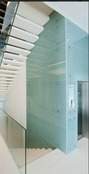
облицовка стен стеклом
